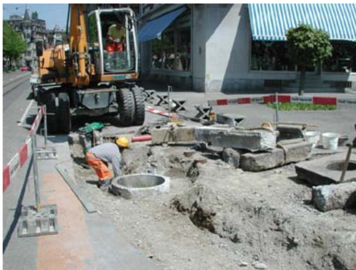
Kanalisationsbau und -unterhalt, Werkleitungsbau, Strassen- und Belagsbau, Erdarbeiten, Erschliessungsarbeiten
